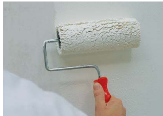
Нанесение поверхностного слоя
